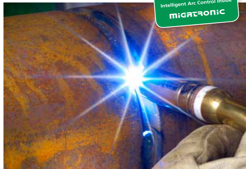
IAC™ - Verticaal neergaand lassen van een grondlaag in een verwarmingsbuis. De lassnelheid wordt aanzienlijk verhoogd ten opzichte van het conventionele stapelen.
