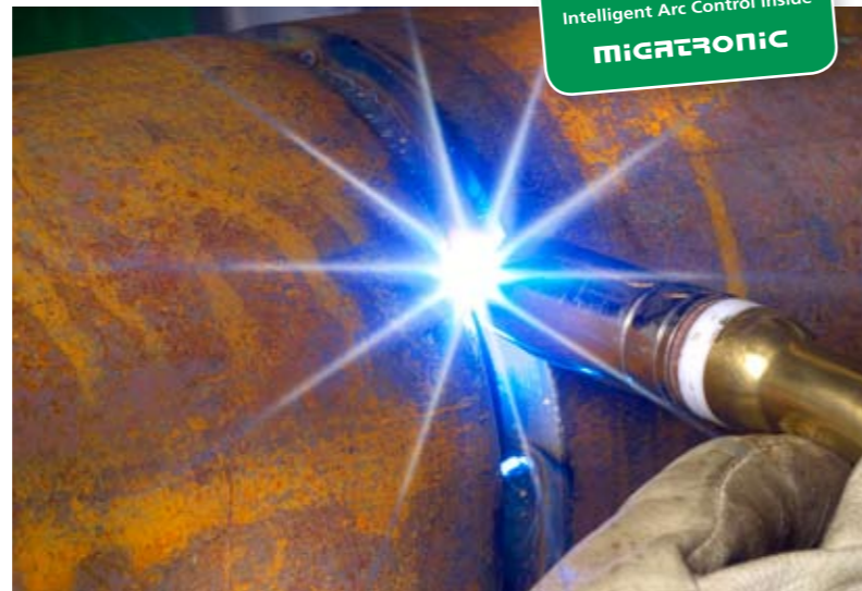
IAC™ - Verticaal neergaand lassen van een grondlaag in een verwarmingsbuis. De lassnelheid wordt aanzienlijk verhoogd ten opzichte van het conventionele stapelen.
